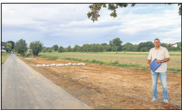
Marco Gretschel vom städtischen Bauamt an der Flutmulde in der Verlängerung des Nikolaiwegs
