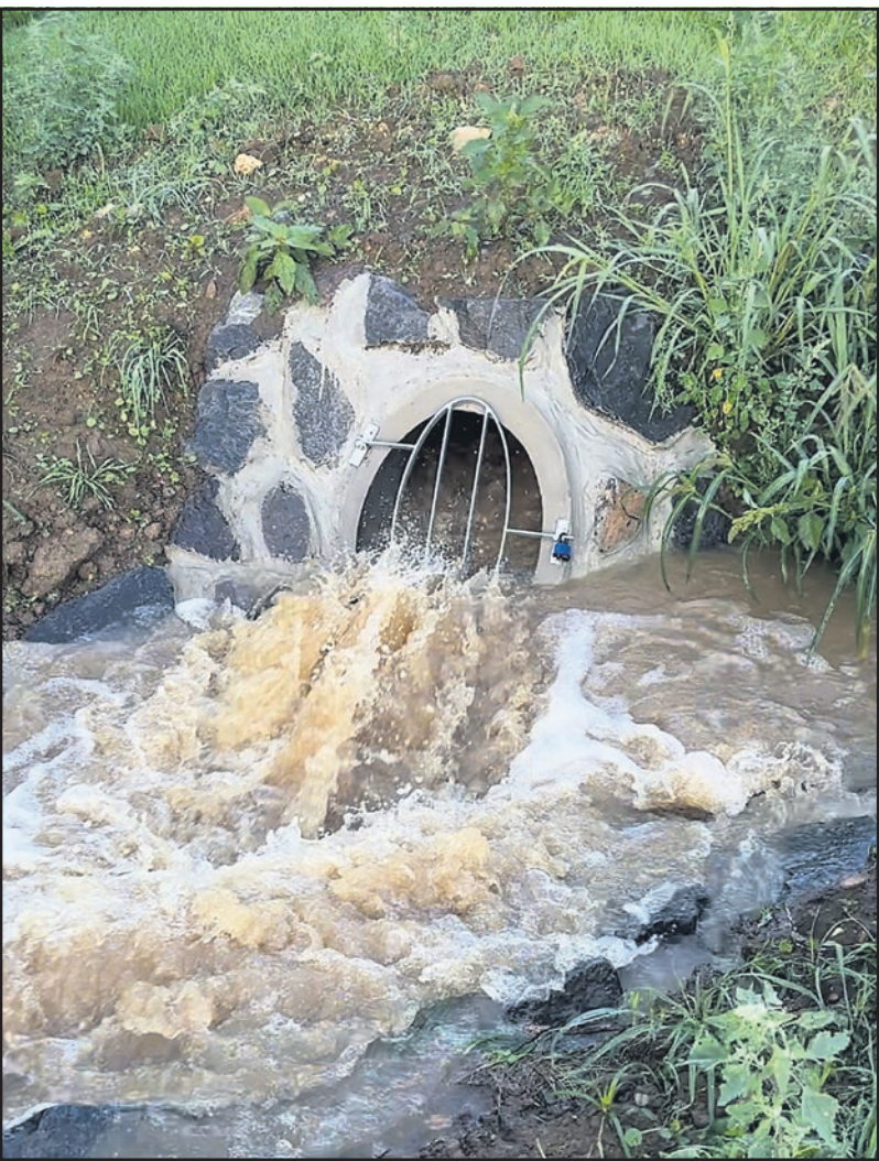
Regenrückhaltebecken Kanal am 16. August 2023
