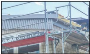
Da die neuen Dachelemente mit ca. 13 Meter so lang sind, wie das halbe Dach breit ist, war eine Woche später fast das ganze Dach erneuert. Das Wetter spielte auch mit, und so konnten die Arbeiten zügig fortgesetzt werden. Denn es war ja auch noch die Isolierung zum Mauerwerk auszuführen, die Regenrinnen zu montieren und sonstige Blecharbeiten zu erledigen.
