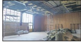
Das 1972 eingebaute Isoliermaterial ist durch die neuen Dachelemente nicht mehr erforderlich. Es wurde verpackt und zum Entsorger abtransportiert.
