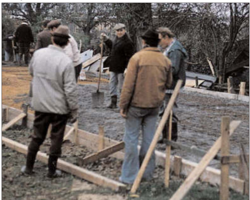
1979: Herstellen der Bodenplatte des neuen Vereinshauses.
