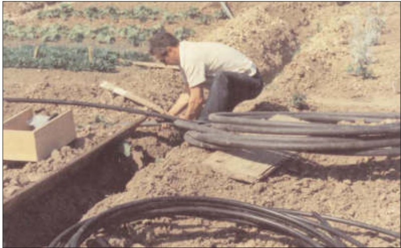
1975: Erschließungsarbeiten Wasserbau, Wassermeister Herbert Leo.
