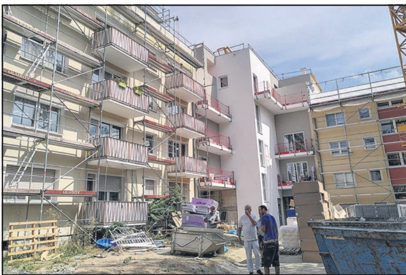
Altes geht und Neues kommt. Die alte Brachfläche bietet jetzt im neuen Verbindungsbau Raum für 15 Wohnungen und eine Tagespflege.
