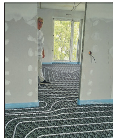
Grüne Blickachsen auf Bäume, die nicht weichen mussten. Der Innenausbau geht rasend schnell voran, die Fußbodenheizung wird bald nicht mehr zu sehen sein.
