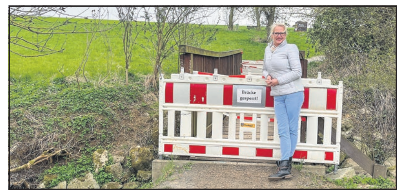
Astrid Gemke steht an der gesperrten Schmetterlingsbrücke in der Steinbachau.
