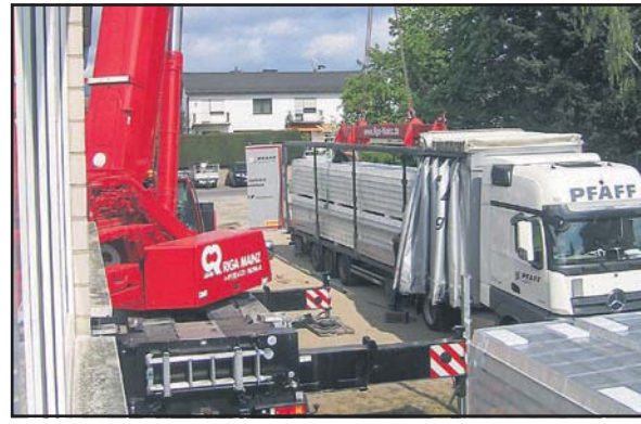
Die 13 Meter langen Teile wurden stündlich angeliefert
