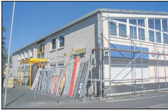
Der Aufbau des Gerüsts hat bereits begonnen
